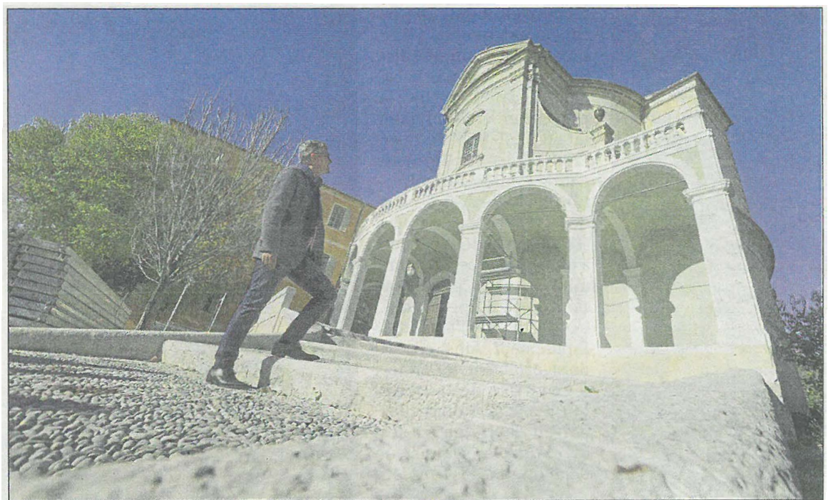
Escalier, façades, toiture et les extérieurs de l'abbaye Saint-Pons ont été réalisés. Les travaux se concentrent à l'intérieur pour rénover tableaux et mobilier. (Photo Frantz Bouton)
