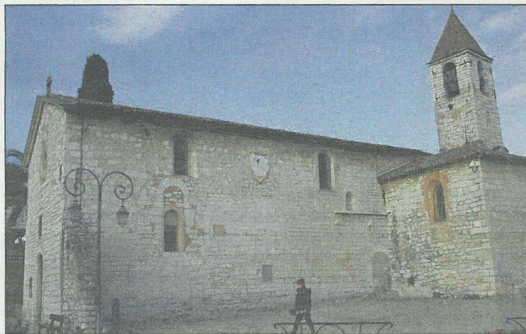
L'église Saint-Grégoire fait l'objet d'une grande restauration, la première phase qui débute porte sur la toiture et le clocher.
